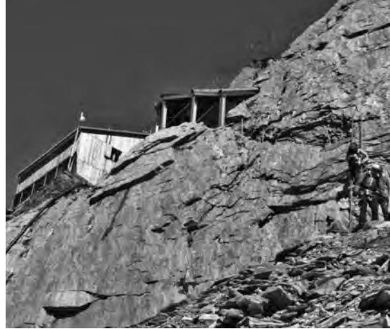
Angeklebt am Felsen, die Oberaarjochhütte. Zugang mit Seil- und Kettenhilfe sowie Leiter und Steinschlaggalerie
