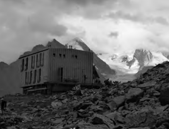
Topalihütte, ein Alpin-Container, aber sehr zweckmässig eingerichtet!
