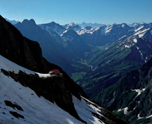
Am Felssporn gelegen – die Cabane L'A Neuve
