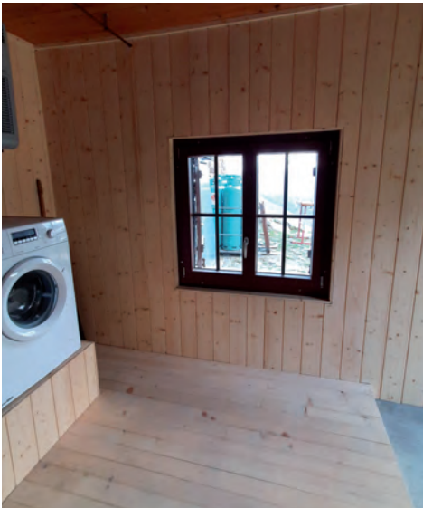
Das Fenster ist jetzt fertig
