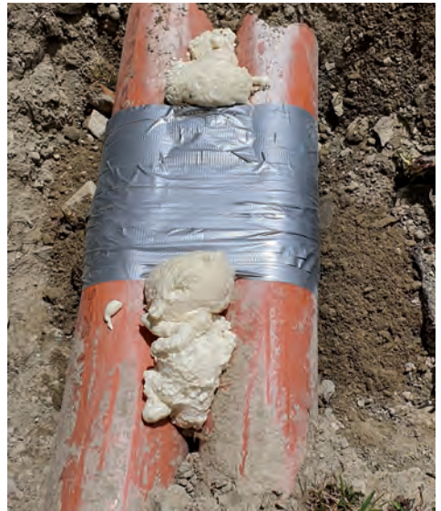
Professionelle Reparatur der Abwasserleitung
