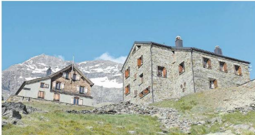
Die Weissmieshütte der SAC Olten in Saas-Grund VS: links die alte und rechts die neue Hütte, die ausgebaut werden soll. Im Hintergrund ist das Loggihorn zu sehen (4010 M. ü. M.). Bild: zug/sac Olten
